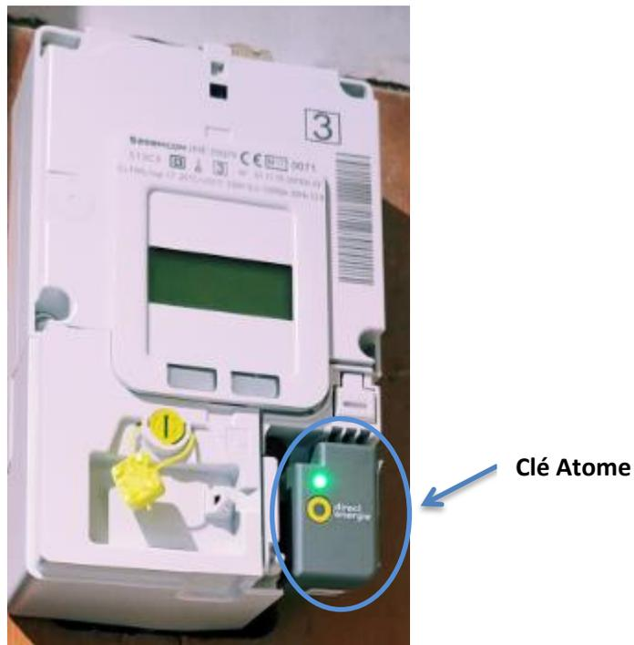
Figure 1 : exemple d'un compteur Linky équipé d'une clé Atome de Direct Energie
