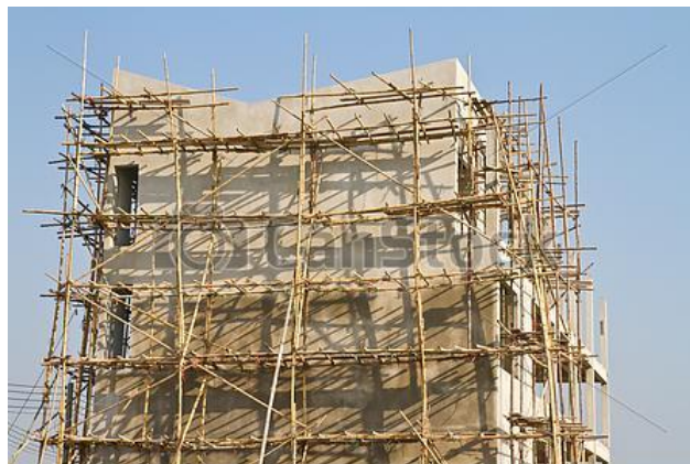
Figure 45 : Echafaudage en bambou
