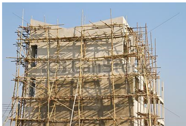
Figure 45 : Echafaudage en bambou
