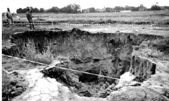
Photo 2. Bétoire sur le chantier de l'autoroute A29
