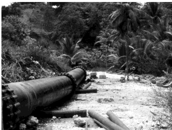
Photo 6. Bourrelet en butée contre la conduite
