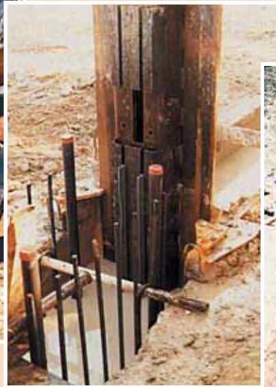
b. Détail du coffrage joint avant bétonnage.
