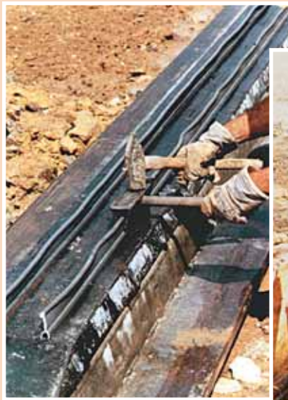
a. Montage des lames Waterstop dans le coffrage joint.
