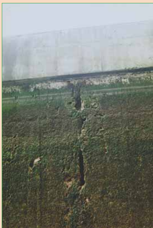
FIGURE 11 - Mauvaise exécution d'un joint.
