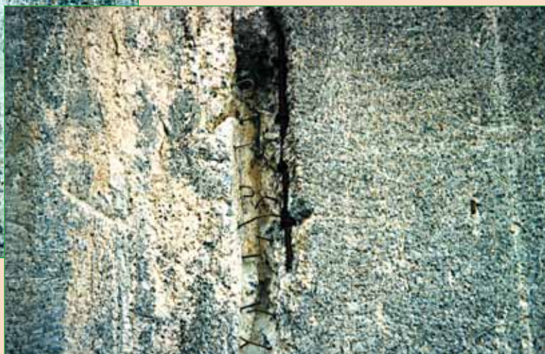
b. Armatures principales et secondaires visibles.
