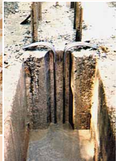
c. Empreinte du joint Waterstop en place dans le panneau précédent.
