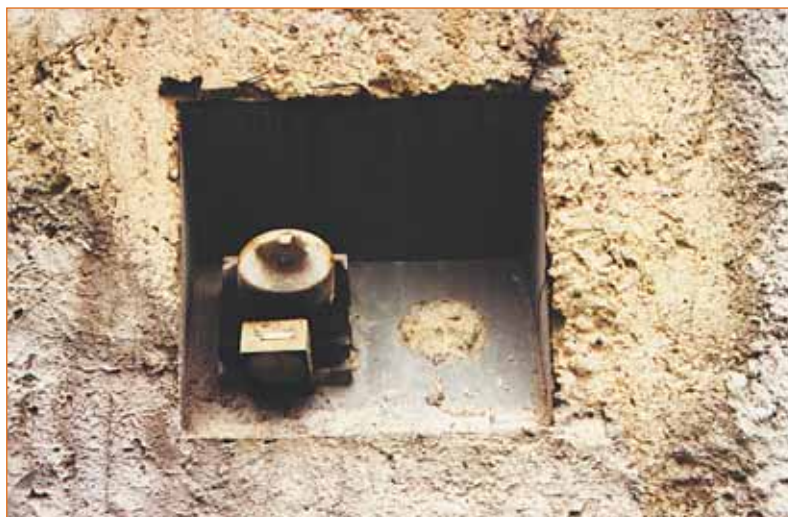
FIGURE 9 - Tirant d'ancrage dans une réservation de paroi, équipé d'un dispositif de contrôle de la tension. (Remarquer la réservation pour tirant complémentaire éventuel).
