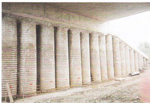
Fig. 10 - Culée et mur en retour réalisés à l'aide d'une paroi de pieux.
