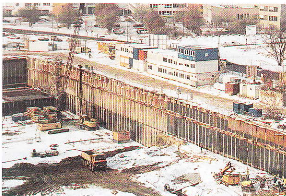
Fig. 7 - Soutènement d'une excavation par un écran de palplanches.
