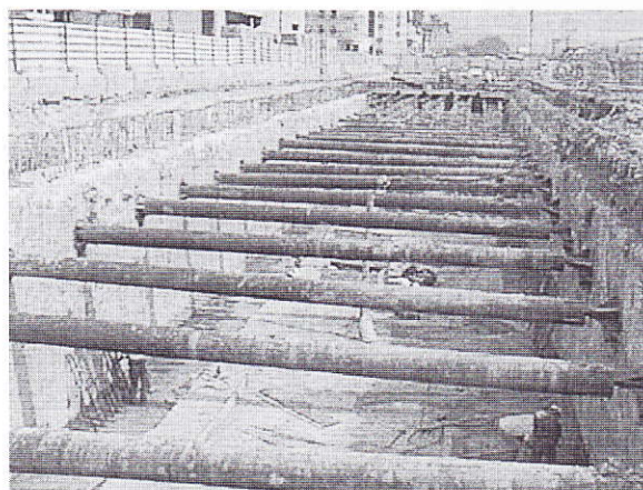
Fig. 15 - Butonnage d'une tranchée couverte en phase provisoire.
