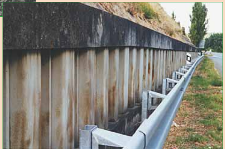
b. Soutènement d'un talus de déblai.
