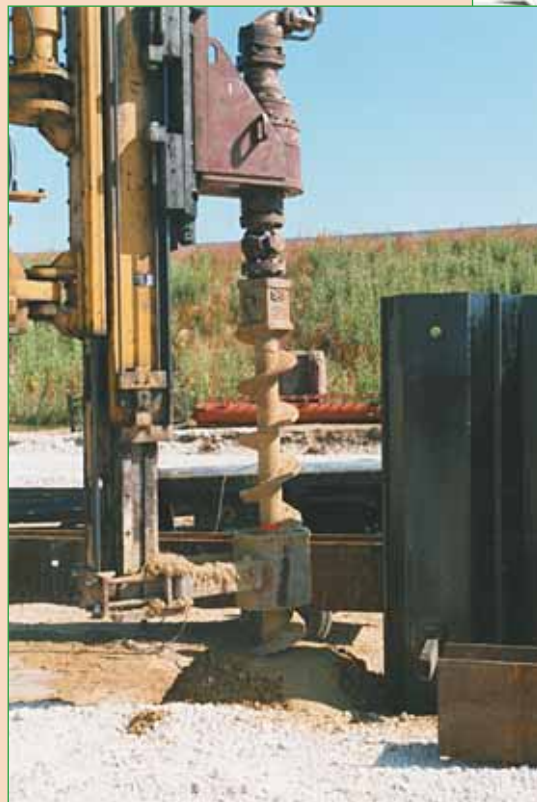
c. Préforage avant fonçage.
