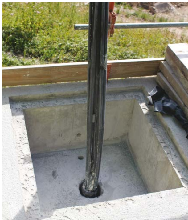
Photo 4.2 : Aménagement d'une réservation sur une crête de barrage (© Freyssinet)
