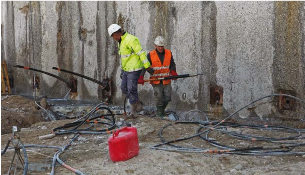
Photo 7.12 : mise en place de l'obturateur (© Spie Fondations)
