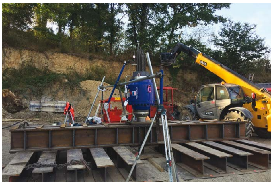
Photo I.1 : Structure d'appui d'essai de chargement (© Soletanche Bachy)
