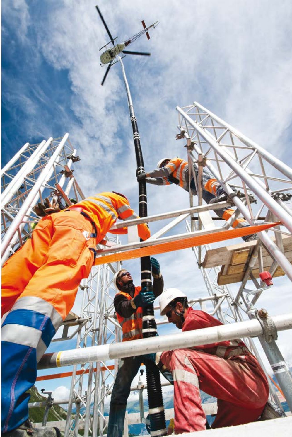
Photo 7.9 : mise en place à l'hélicoptère (©Cédric Helsy- Soletanche Bachy)
