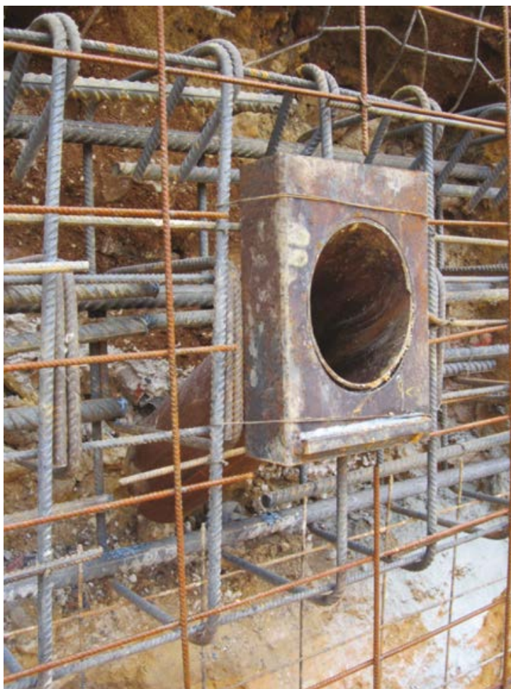
Photo I.2 : Réserve dans voile en béton projeté (© Soletanche Bachy)
