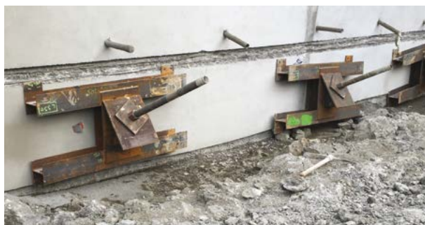
Photo 3.3 : exemple de système d'appui (© Franki Fondation)
