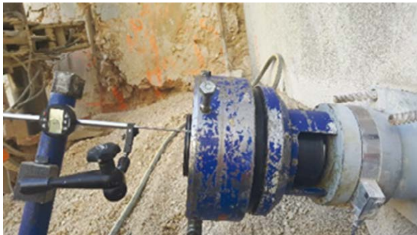
Photo 8.10 : pesage d'un tirant avec tête instrumentée (© Freyssinet)
