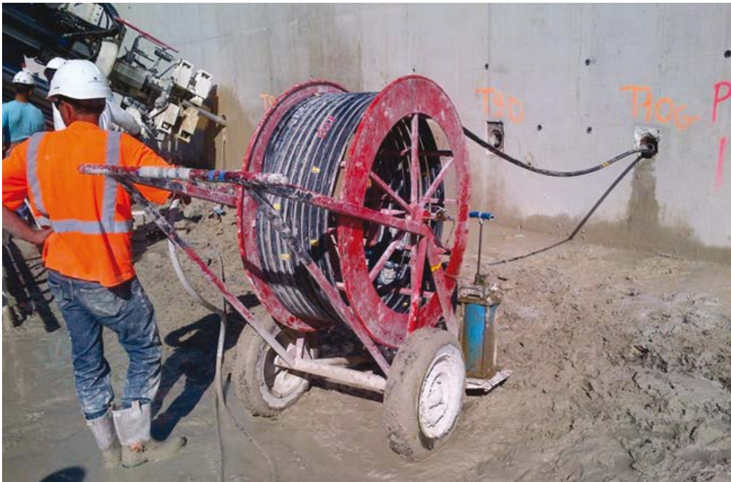
Photo 7.13 : injection de type IRS (©Freyssinet)
