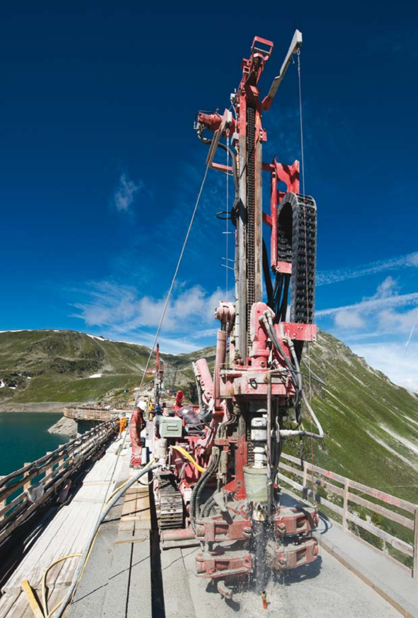
Photo 7.2 : foreuse sur un barrage (©Cédric Helsy- Soletanche Bachy)
