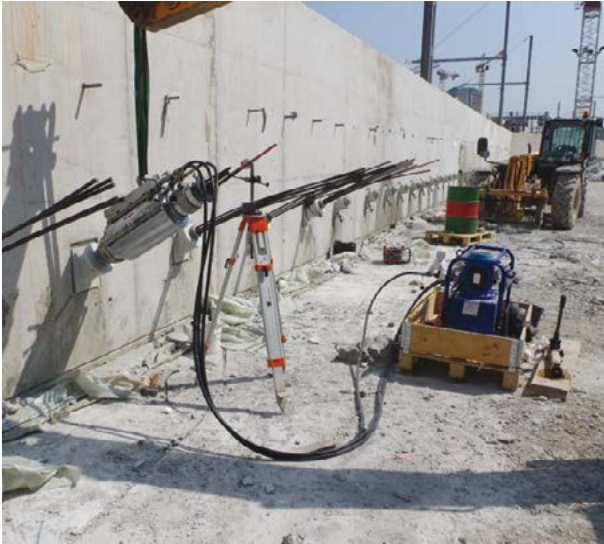
Photo 8.4 : essai de contrôle (© Soletanche Bachy)
