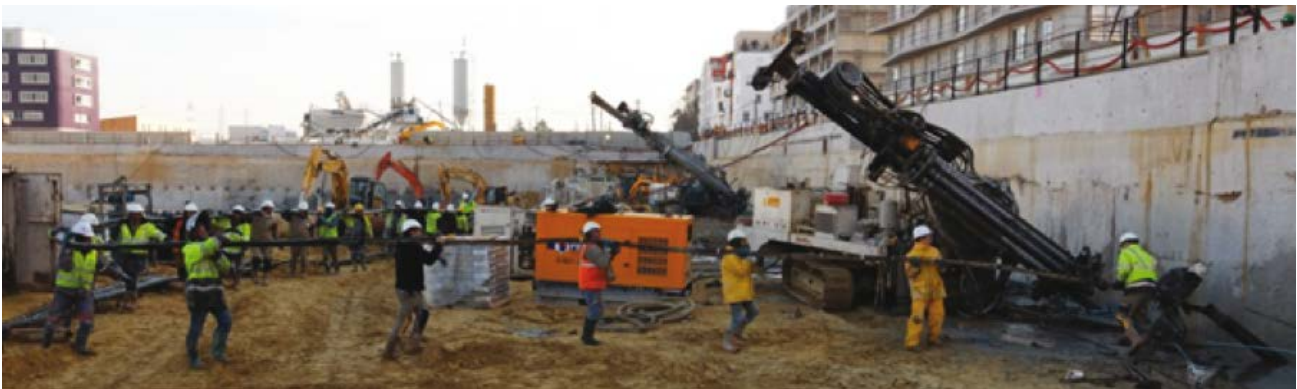
Photo 7.8 : mise en place manuelle du tirant (© Sefi Intrafor)
