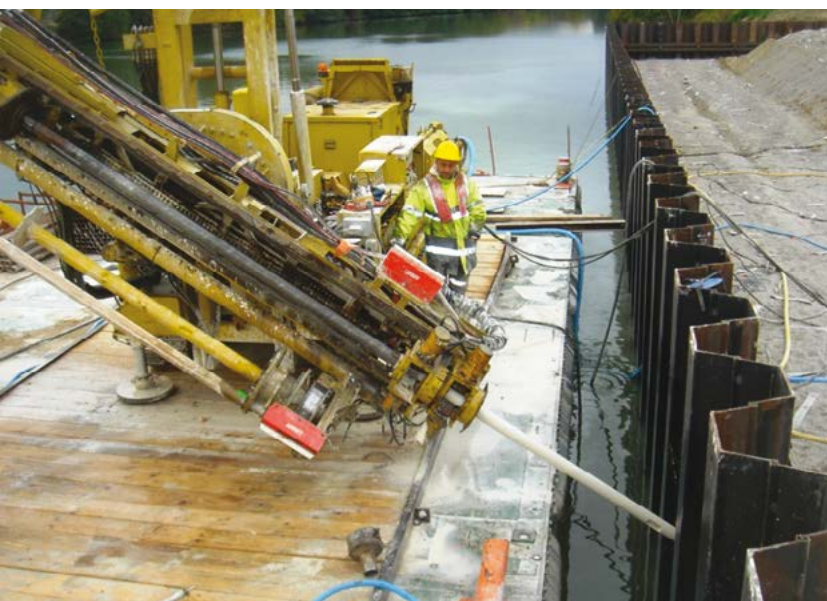
Photo 7.4 : foreuse installée sur une barge (© Sefi Intrafor)
