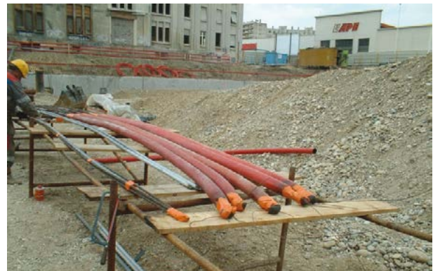
Photo 6.2 : Remarquer la gaine de la partie libre de ces tirants en cours d'assemblage sur site (© Sefi Intrafor)
