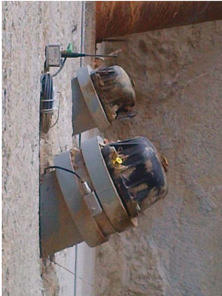
Photo 8.6 : Tête d'ancrage instrumentée avec signal radio (premier plan) (© Freyssinet)
