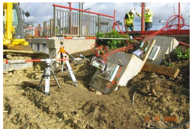
Photo 8.1a : massif de réaction en béton pour essai à la rupture (© SMG)
