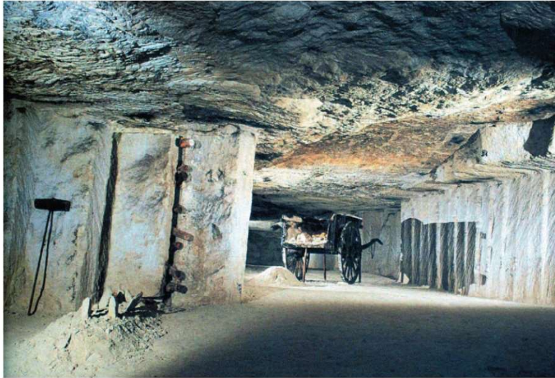
Figure 2 Vue d'une zone d'extraction d'une carrière souterraine (carrière de Bourré - Loir-et-Cher) (les coins, le maillet et la charrie permettant l'extraction sont remplacés à des fins pédagogiques)
