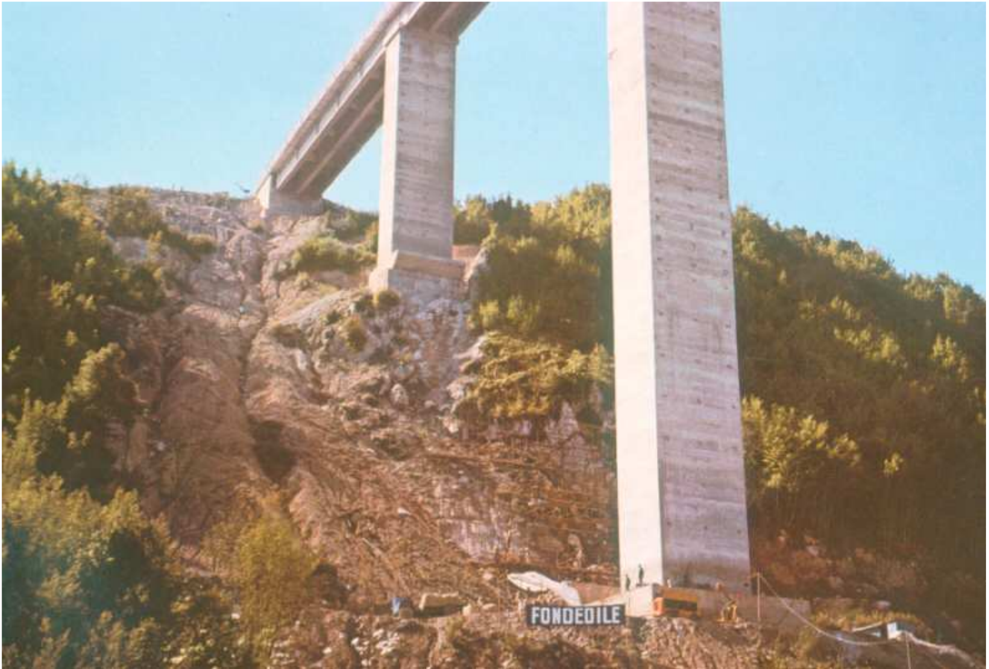
Fondations de ponts sur massifs rocheux
