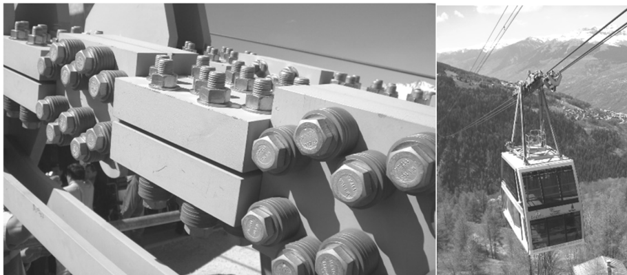
Figure 8-32 : Ancrage de sécurité, Mors boulonnés de serrage du câble
